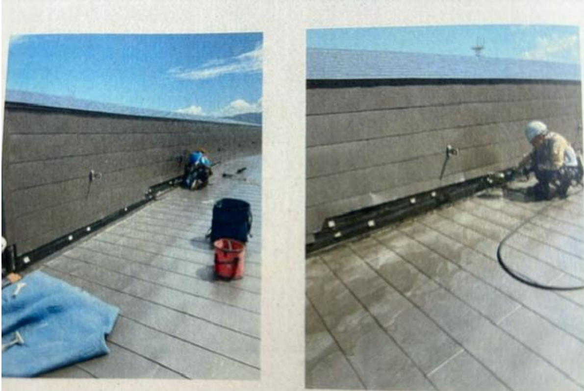
写真.20 板金剥ぎ取り、散水試験状況
